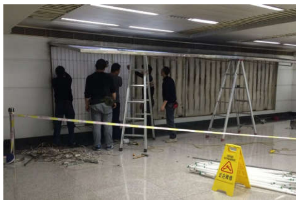
杭州机场正进行更新 LED 光源工程
